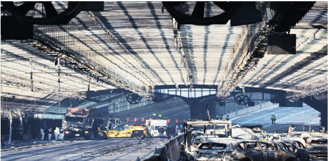
<그림 3-20> 갈현고가교 방음터널 화재진압 후 모습
