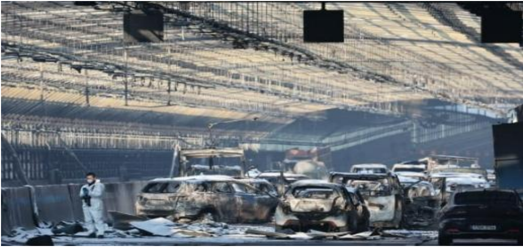
<그림 3-22> 수원 - 용인 방음터널 화재진압 후 모습
