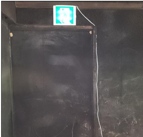
<그림 4-7> 실험장 내 유도등 설치 사진
