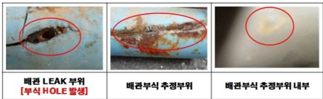
<그림 3-1> 2012년 OO캠퍼스 옥외소화배관 육안 점검 및 내시경 점검 결과
